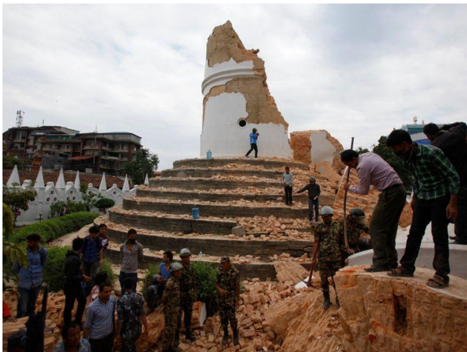
Εικ. 4. Ο πύργος Dharahara στην Κατμαντού ερειπωμένος.
